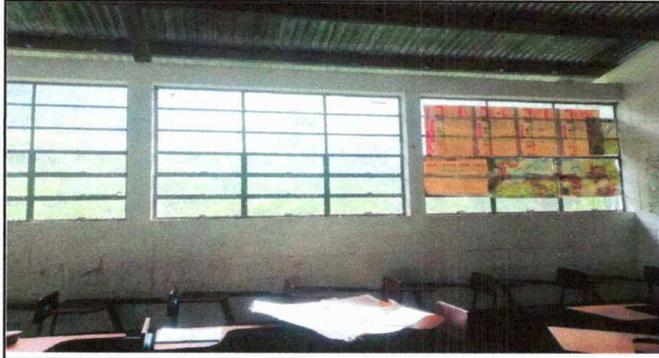
Foto1: Se observa en area de ventanería piezas de vidrio en mal estado
